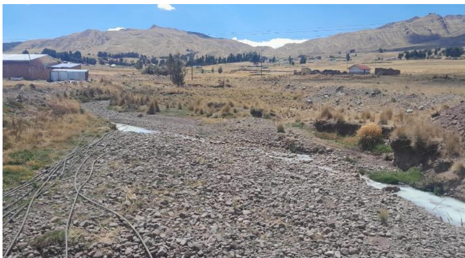
FIGURA N°03: CAUCE DE LA QUEBRADA ANTAHUAYCCO SE ENCUENTRA COLMATADO Y EXPUESTO A SER AFECTADO POR LAS PROXIMAS AVENIDAS .
