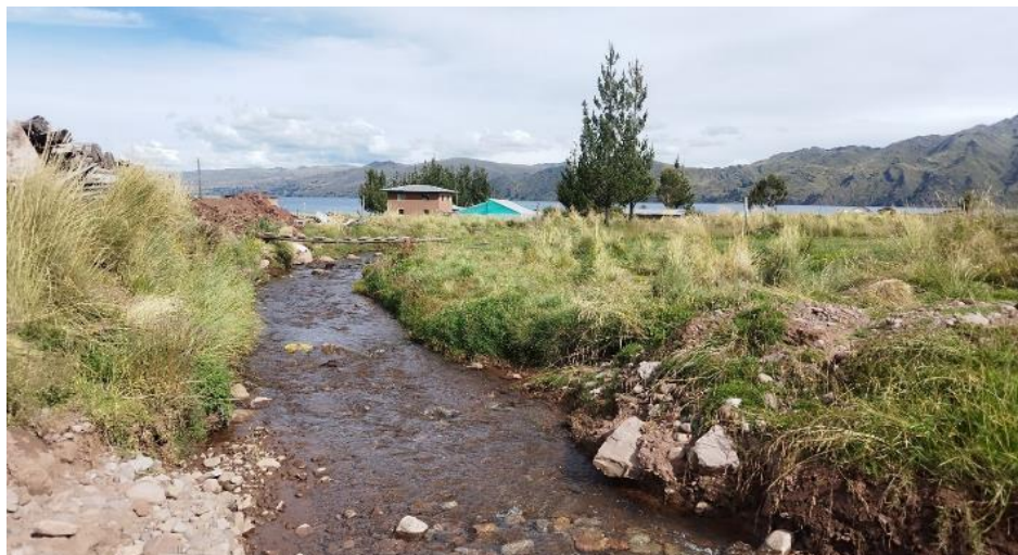
FIGURA N° 01: CAUCE DE LA QUEBRADA ESTRANGULADO Y SE APRECIA TALUDES NATURALES SIN DEFENSA RIBEREÑA, LOS CUALES SE ENCUENTRAN EXPUESTOS ANTE UNA CRECIDA DE LA QUEBRADA ANTAHUAYCCO.
